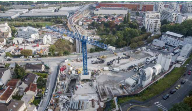
↓ Exemple de base arrière logistique lors d'un creusement au tunnelier sur le prolongement de la ligne de métro 11 (puits d'entrée du tunnelier). Source : RATP
